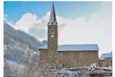
Die Kirche in Troistorrents wurde 1722 erbaut. Nun müssen Mauern und Gewölbe saniert werden. Bild: zVg
